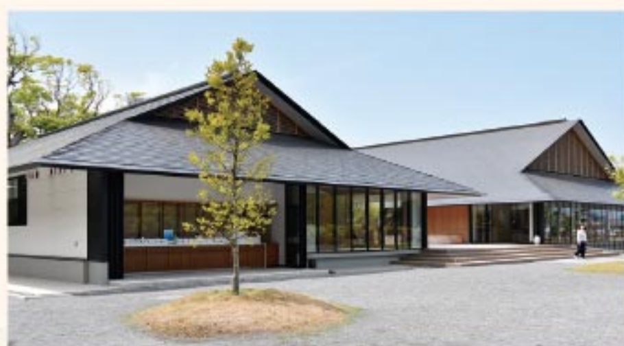
写真上:新しい社務所(左)と祈願殿 写真左:沖ノ島周辺を模した庭
