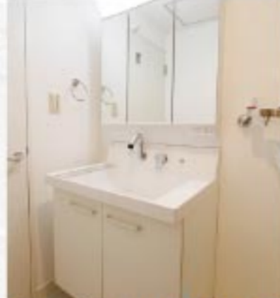
洗面スペース 温水洗浄便座、シャンプードレッサーを設置済み。自動お湯はり・追い焚き機能も完備。
